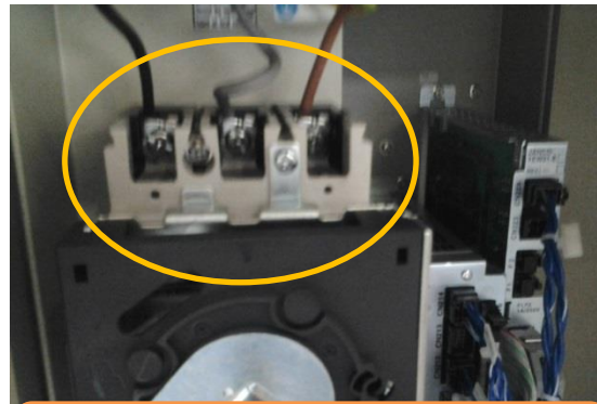
在断路器上连接电源线(AC200V)
