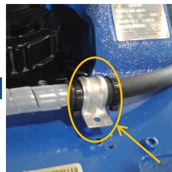
在地线上安装鞍板
