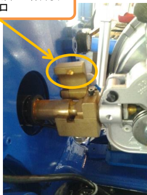
取下防拔固定螺栓，打开安装口
