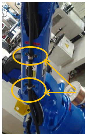
在机械手上安装地线 (更换安装螺栓)
